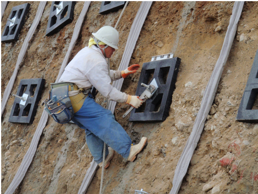
写真 EP 受圧板設置状況の一例
